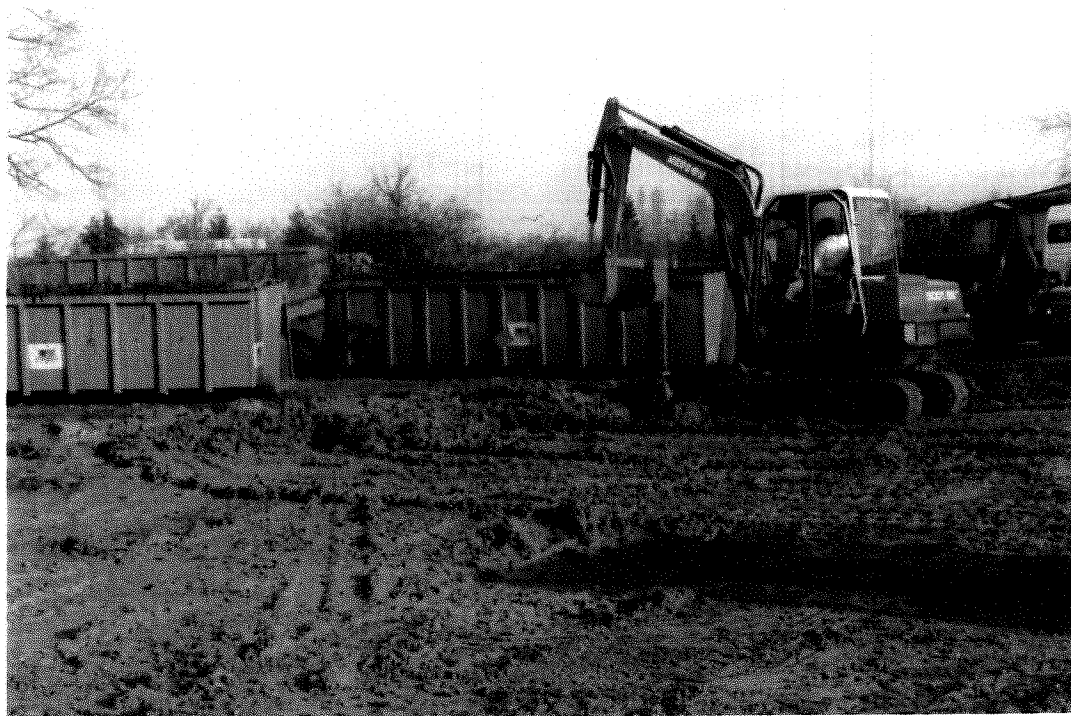
Photo 13 : le décapage des terres
