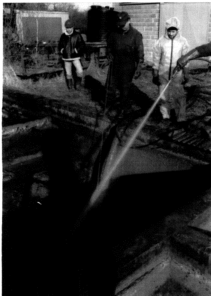
Photo 12 : nettoyage du décanteur
