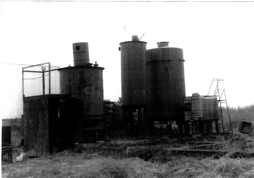
Photo 7 : des cuves sur le site
